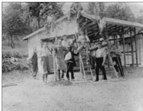
Arbeiten auf dem Turnplatz 1923.
