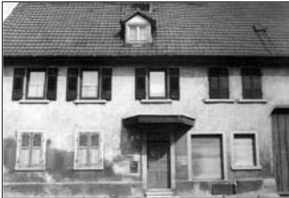
Gründungslokal Gasthaus zur „Sonne“ in der Bietigheimer Straße .
